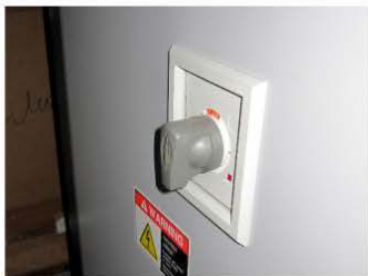
1. Встроенный защитный автомат
