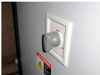
1. Встроенный защитный автомат
